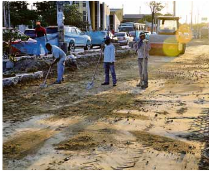
Trabajadores retomaron ayer las obras.
