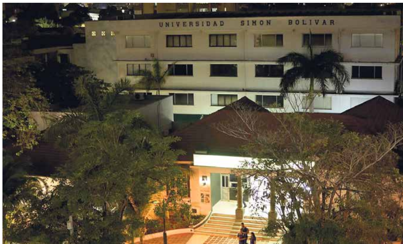
Fachada de la Sede 1 de la Universidad Simón Bolívar.
